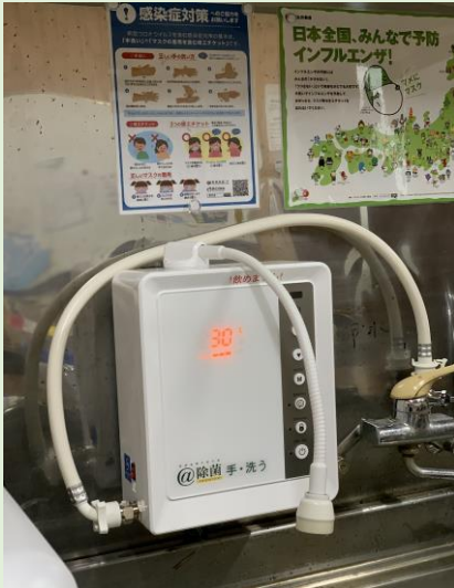
竹葉建設内設置
