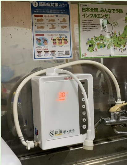
竹葉建設内設置
